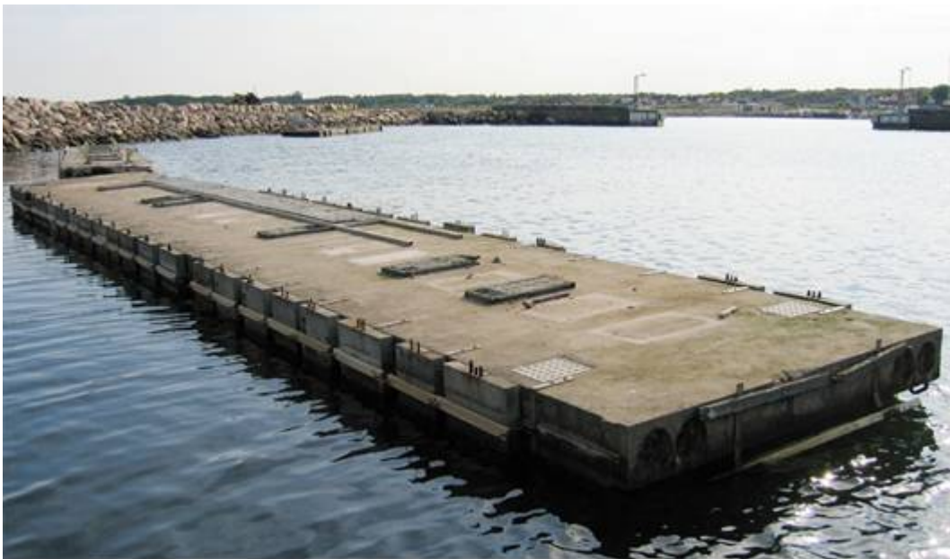
Figure 1 – Swedish field site at the Träslövsläge Harbour, Varberg.
